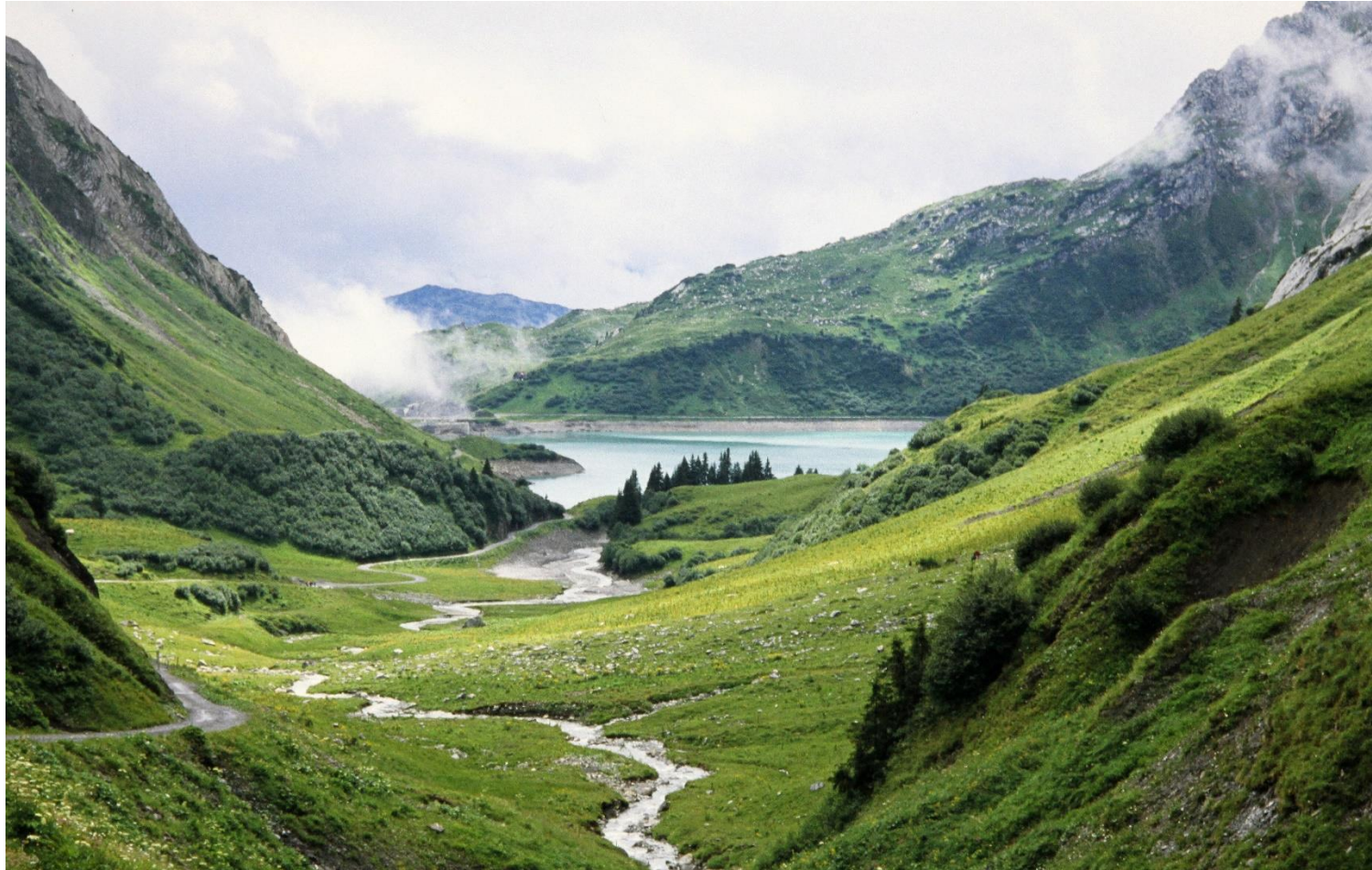
Spullersee. Mit 2 Staumauern künstlich aufgestaut. Man nutzt die Wasserkraft zur Stromgewinnung; hier zur Stromversorgung der Bahnlinie Bregenz – Innsbruck.
